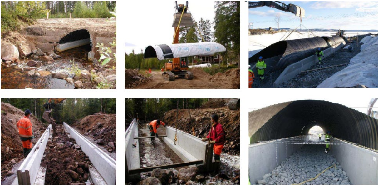
Figur 13 - Trenchcoat på fundament - Kilde Viacon
