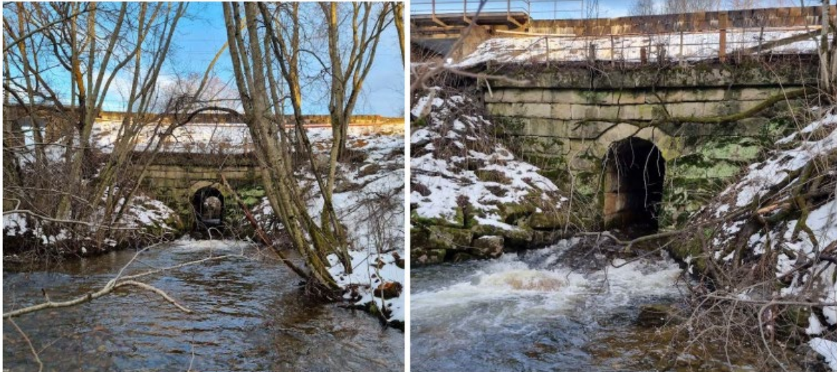
Figur 1 - Lodbekken steinhvelvskulvert fra utløpet
